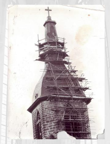
Bei den Außenarbeiten wurden Putzschäden und Mauerwerk erneuert und Teile der hölzernen Turmspitze renoviert. Zum Abschluss der Arbeiten wurde der Preußische Adler von der Turmspitze durch ein Kreuz ersetzt.
